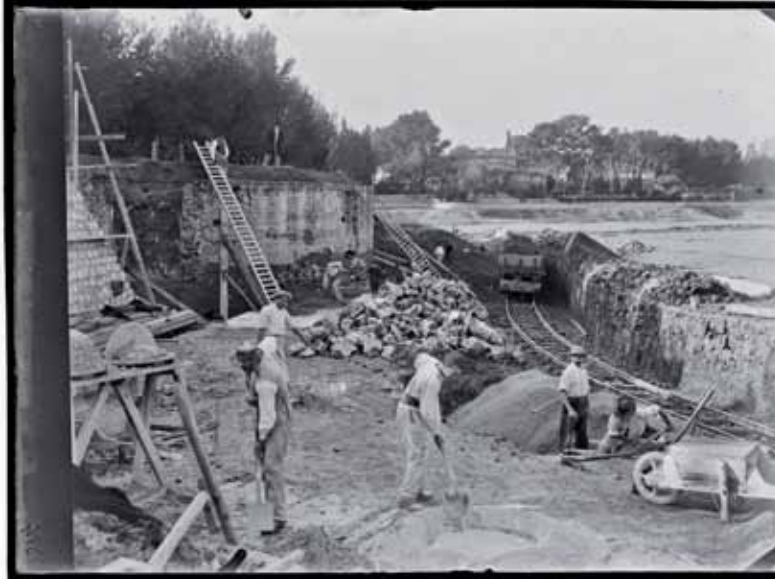
Ouvriers italiens travaillant sur les chantiers de la Société du canal de Marseille 1898-1899. Source : Archives municipales de Marseille (16 Fi 19).
